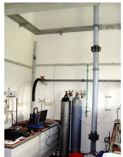
Pilotanlage zur Biogas-Wäsche
