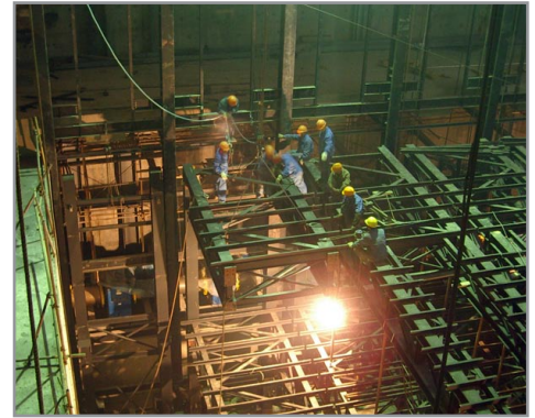
Einbau der SBS-Bühnentechnik in das Theater Hangzhou. Die von SBS entwickelte Bühnensteuerung steuert in Ober- und Untermaschinerie insgesamt 124 Achsen.
