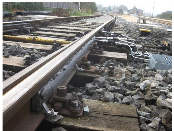
Die in Deutschland am häufigsten verwandten Weichenheizungen werden elektrisch betrieben. Diese zeichnen sich durch hohe Betriebssicherheit aus. Andererseits sind diese Systeme sehr energieintensiv.
